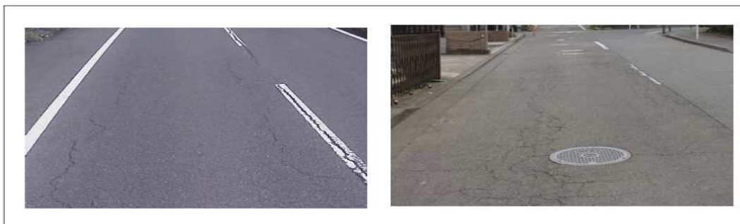
ひび割れ率 20～40%程度の例
